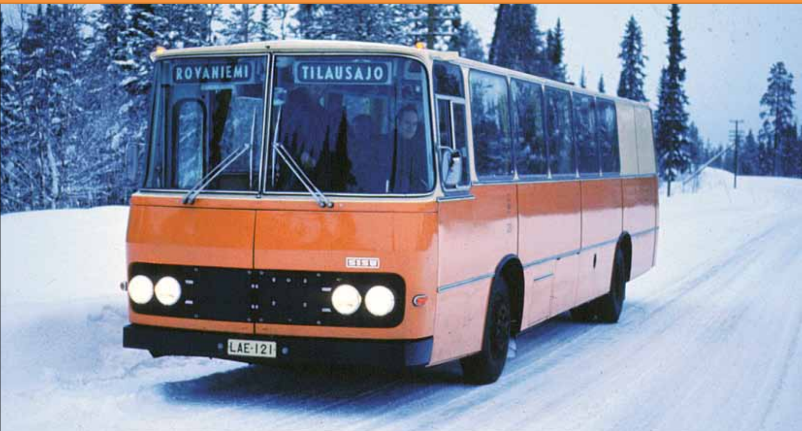
Ajokki 5000-sarjan koreilla olevista Sisuista tuli 70-luvun peruspostiautoja. Kuvan auto on vuonna 1973 rekisteröity keskimoottorinen Sisu BK-82SP (sivunumero 72301). Tämä malli oli Vanajan keskimoottorialustan Sisu-versio, jota valmistettiin Hämeenlinnassa Vanajan entisellä tehtaalla. Alustassa oli liikaa Vanajaa, jotta se olisi sopinut Sisun mallistoon, eikä näitä tehty muille kuin Postille. Posti oli suuri asiakas, eikä heille kelvannut tässä vaiheessa mikään korvaava Sisun malli. Kuvat: Ajokki
